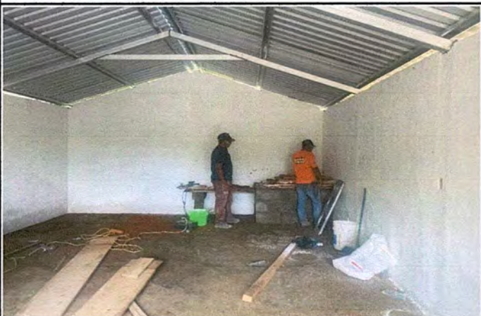
Foto 3: finalización de la cocina parte interior con un 90%
