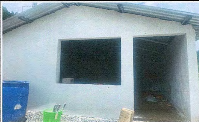
Foto 1: finalización de la cocina parte exterior con un 90%
