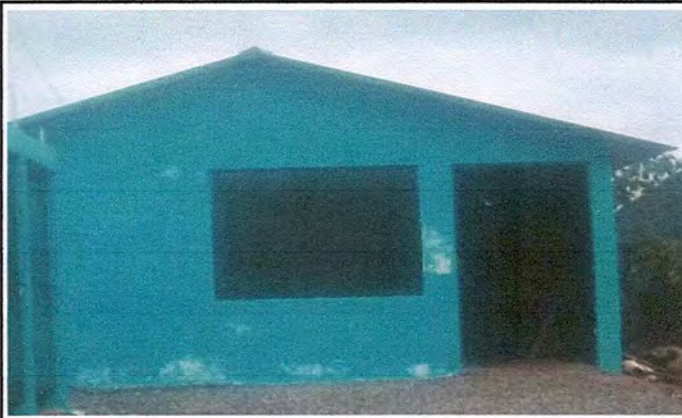
Foto 2: finalización de la cocina parte exterior con un 100%
