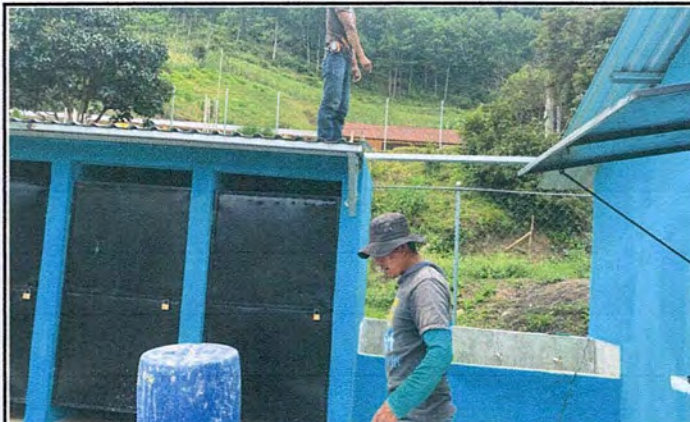
Foto 2: finalización de baños y lavamanos
