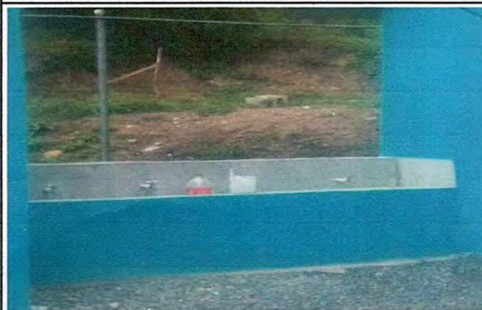
Foto 3: finalización de lavamanos
