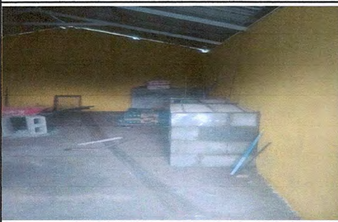
Foto 4: finalización de la cocina parte interior con un 100%
